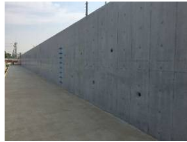
平成28年5月 擁壁く体工事 状況 ※敷地外周に設置
