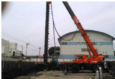
平成28年6月 山留工事 状況
