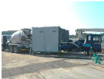
ひきつづき、基礎く体工事をおこないます。コンクリート打ちこみ時には50～100台程度のコンクリートミキサー車の搬出入があります。目久尻川沿いの道路は安全を考慮し、徐行運転を実施いたします。コンクリート打ちこみ時には騒音対策をおこないます。（写真－防災調整池コンクリート打ちこみ状況）
