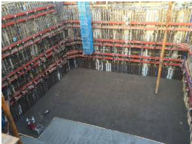
H28年11月 ごみピット掘削 完了
