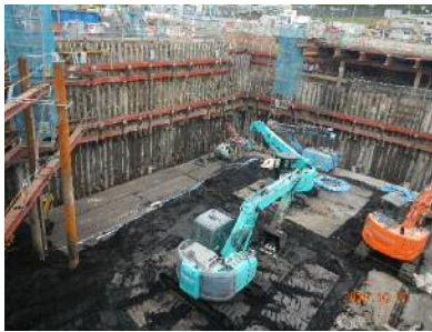
H28年10月 ごみピット掘削 状況
