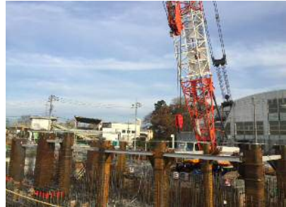
H28年12月 鉄骨工事 状況
