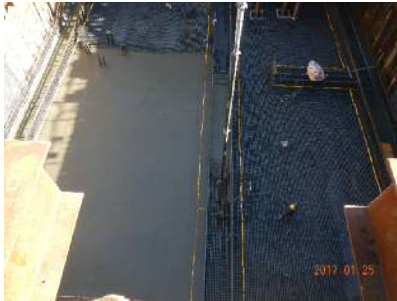
H29年1月 ごみピット底盤コンクリート打設状況
