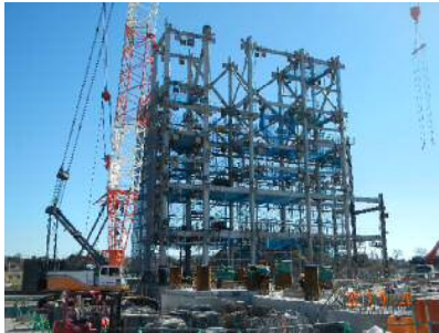
H29年1月 鉄骨建て方状況
