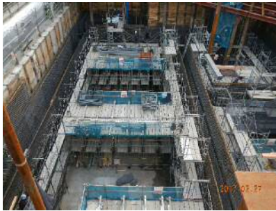
H29年2月 ごみピットく体工事状況
