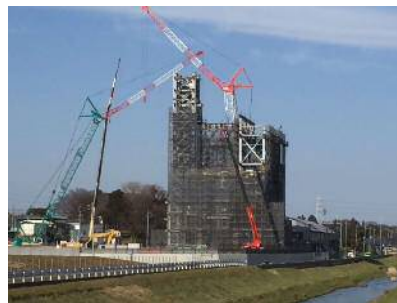
H29年3月 鉄骨建て方状況
