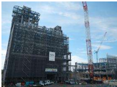
H29年5月 鉄骨建て方状況
