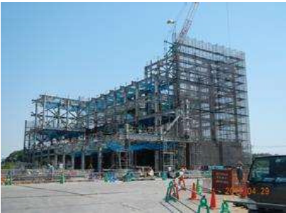
H29年4月 鉄骨建て方状況
