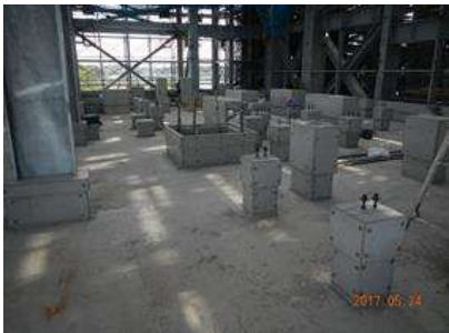
H29年5月 各階く体工事状況
