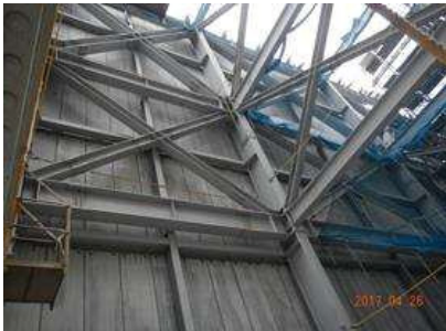
H29年4月 外壁工事状況
