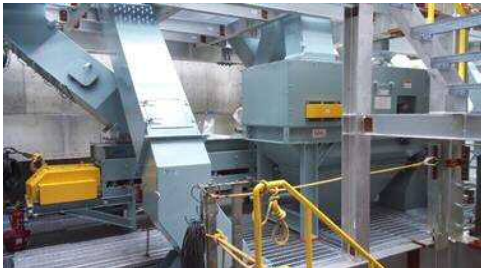
H29年10月 リサイクルエリア据付状況
