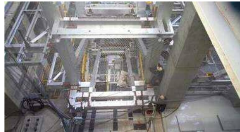
H29年11月 炉室鉄骨建方状況
