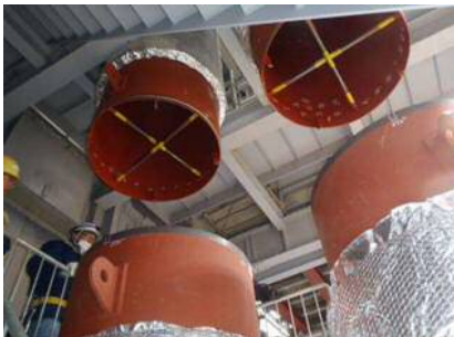
H30年2月 煙突内筒組立工事
