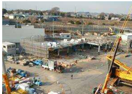
H30年2月 駐車場棟 鉄骨工事
