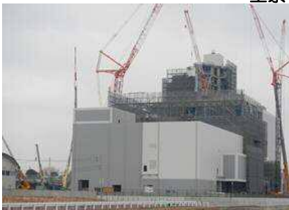
H30年2月 工場棟 南側外装工事完了
