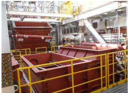
H30年2月 ボイラ組立工事
