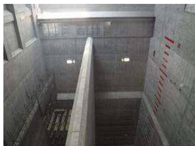
H30年5月 ごみピット状況
