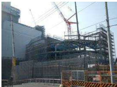
H30年4月 プラザ棟鉄骨工事状況
