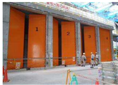
H30年4月 ごみ投入扉据付
