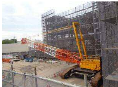
H30年4月 350tクレーン解体
