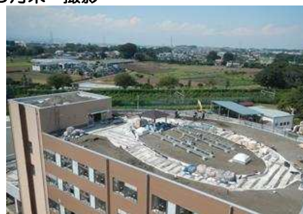
H30年8月 プラザ棟屋上工事
