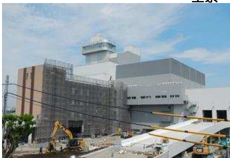
H30年7月 外構工事状況
