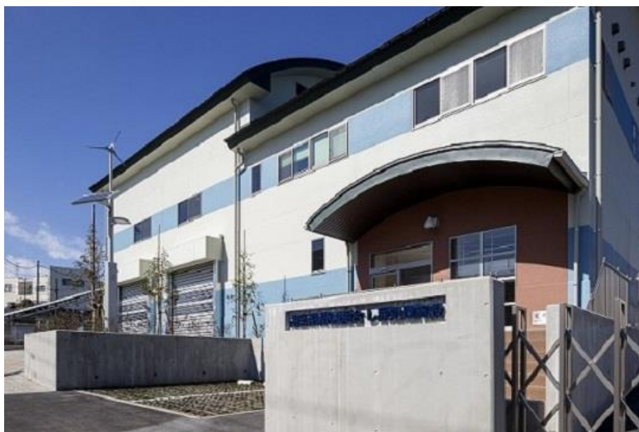
高座清掃施設組合水処理施設
