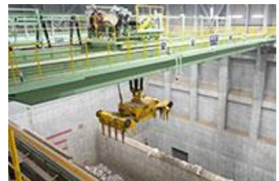
高座清掃施設組合処理施設
